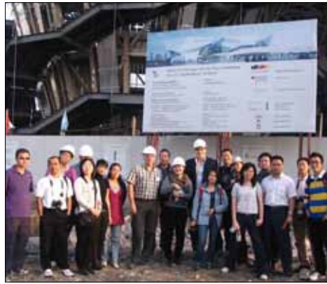
Besuch: eine Gruppe chinesischer Journalisten auf der Baustelle von balancity
